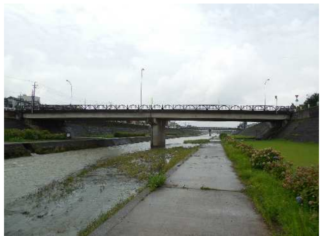
写真全景（コンクリート橋）
