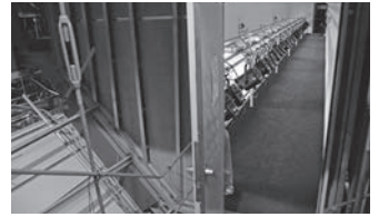
客席天井裏 (吊り天井とライト)
