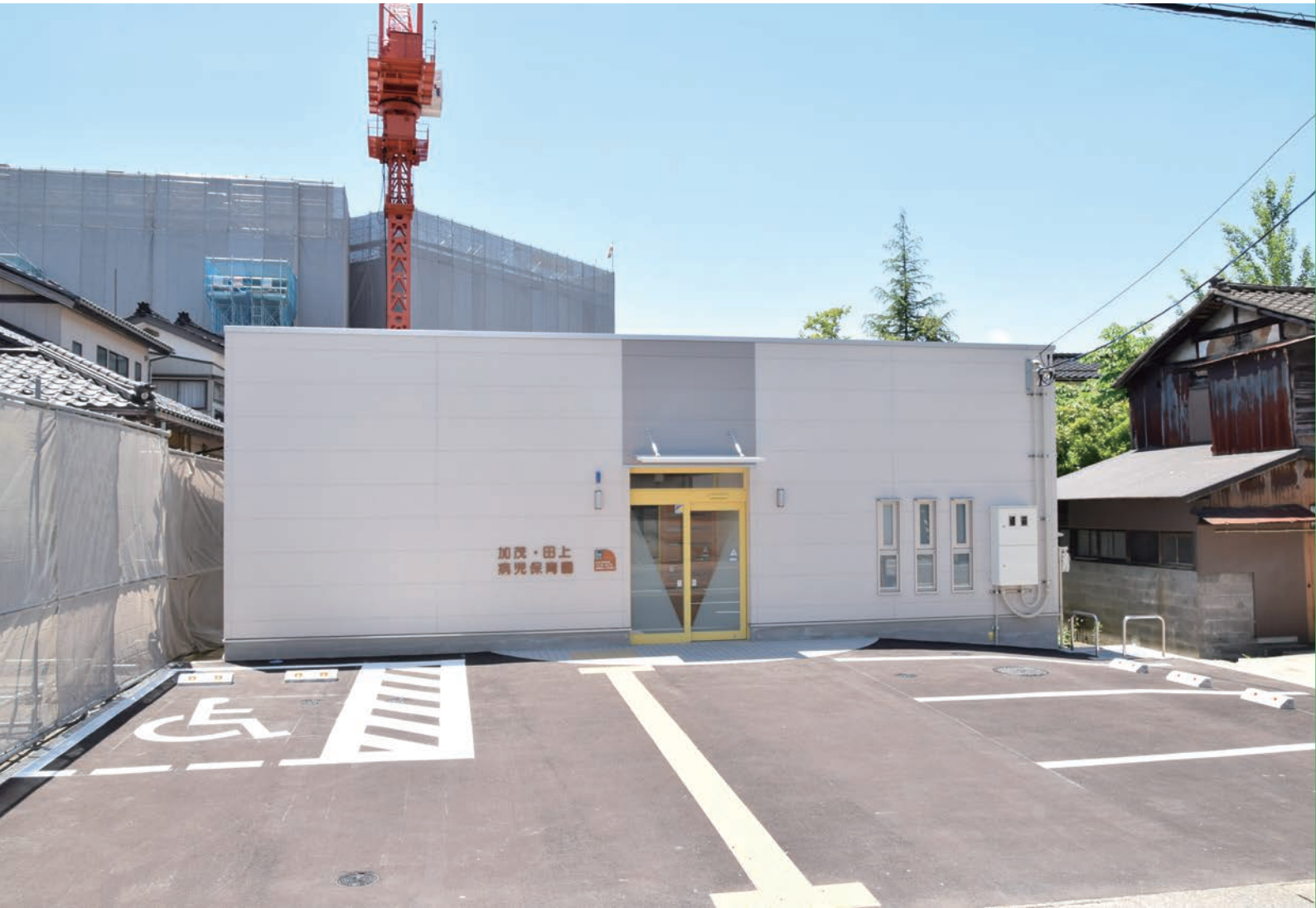
完成した加茂・田上病児保育園、後ろは建て替え工事中の加茂病院新病棟
