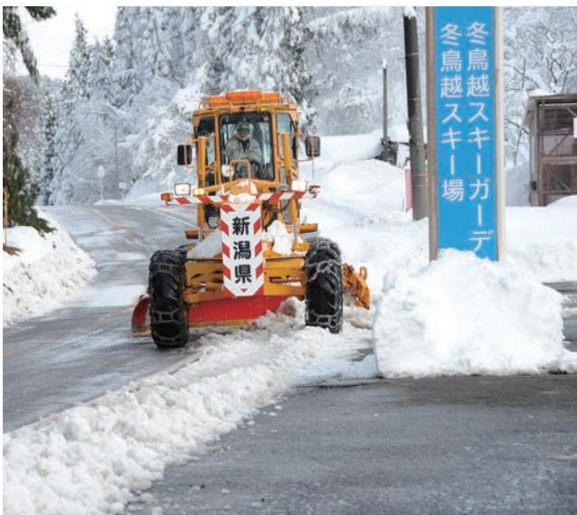
冬鳥越スキーガーデン前の国道290号線の除雪
