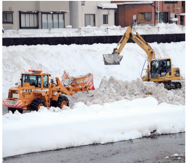
加茂川河川敷の雪捨て場
