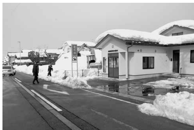
■狭口駐在所移転新築（2月14日） 地域の安全を守ってきた狭口駐在所が道路向かいに移転新築されました。地域の皆さんが相談に訪れやすいようにと造られています。
