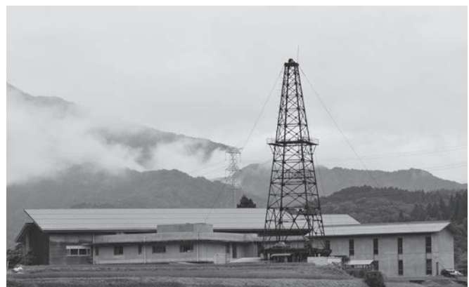
強風で倒壊の危険性が生じ、解体が決まった美人の湯の槽
