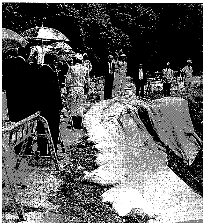
産業建設常任委員会の現地視察（下条地内災害箇所）
