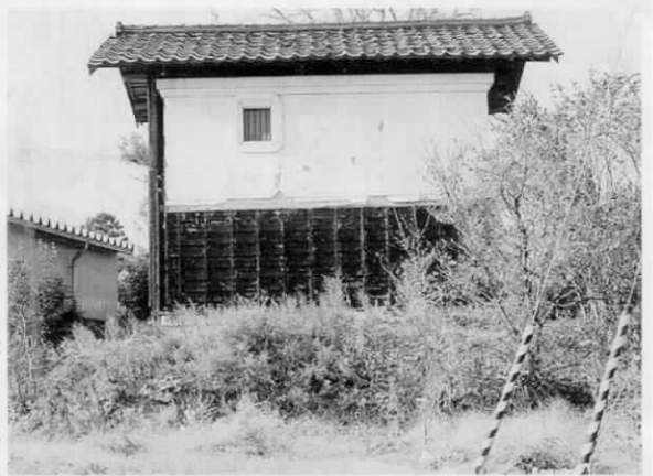
▶ 高さ約四・五尺の土盛りの上に建つ水倉。漆喰壁で、雨板の上部が剥き出しになっている。
