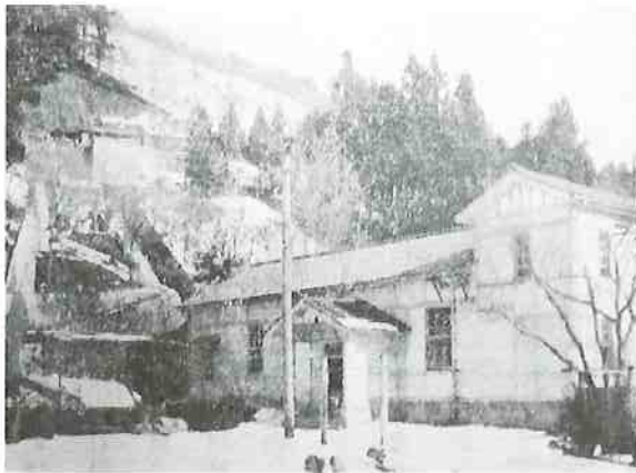
▲新潟水力電気早出川第一発電所（現五泉市）ここから加茂・三条へも電気を供給した。
