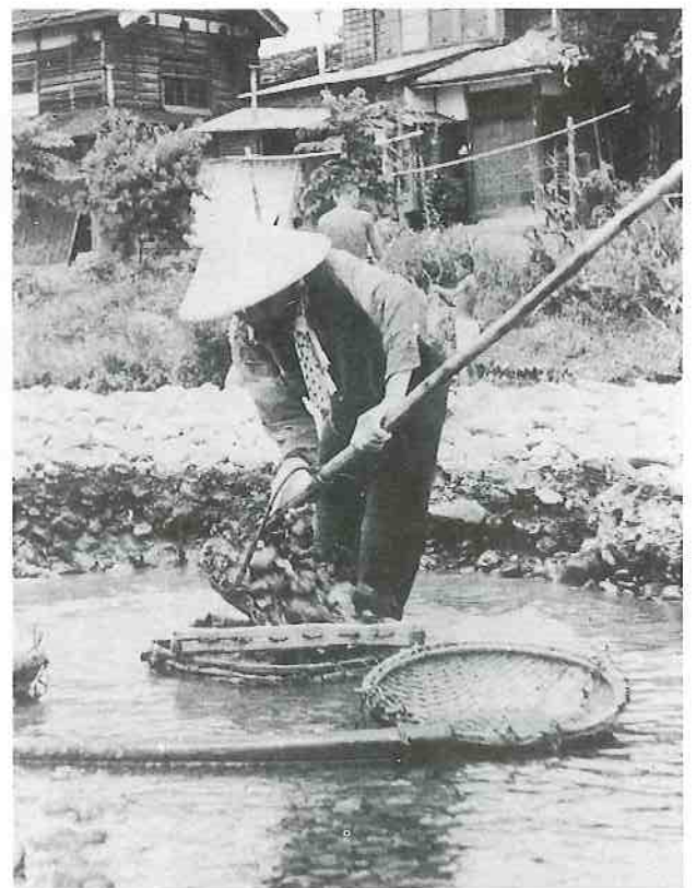
▲ 加茂川での川砂利採り（昭和20年代）川砂利も川砂同様人力で採取し、川砂及びセメントと調合され建築材としてのコンクリートになった（本間 正氏所蔵）
