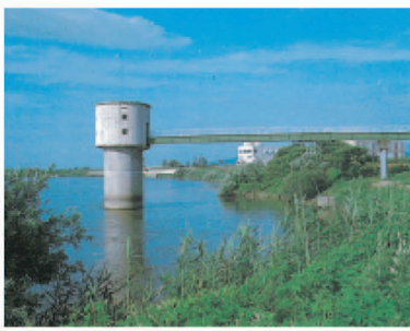
信濃川取水塔
