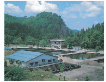
宮寄上浄水場
