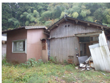
▲危険な空き家の除去
