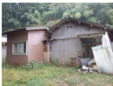
▲危険な空き家の除去
