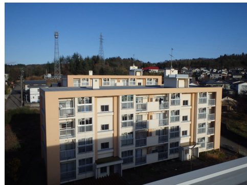
▲公営住宅（学校町団地）
