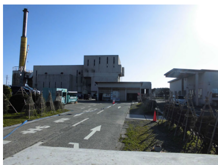
▲加茂市・田上町消防衛生保育組合清掃センター
