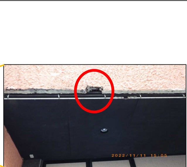
エントランスの上部コンクリート欠落箇所（3の詳細及び欠落箇所）
