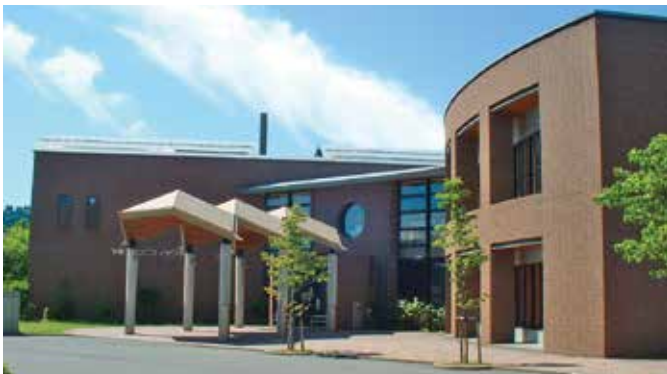
修繕が必要な下条コミュニティセンター
