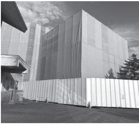
耐震改修工事中の石川小学校
