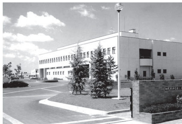
加茂市浄化センター（外観）
