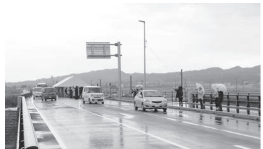
下条川にかかる「新下条川大橋」
