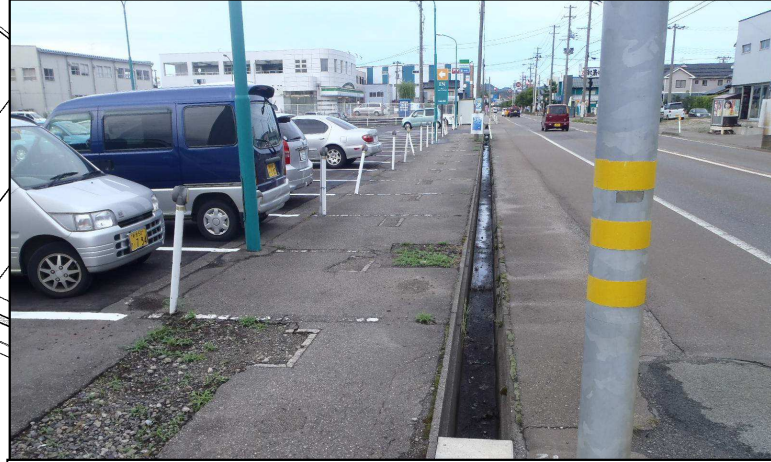
【国道403号線 リオンドール駐車場前】 (交通量の多い)車道と歩道の区別が外側線しかなく危険。
