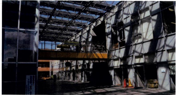
普通教室棟と生涯学習棟をつなぐ2階テラスとブリッジ
