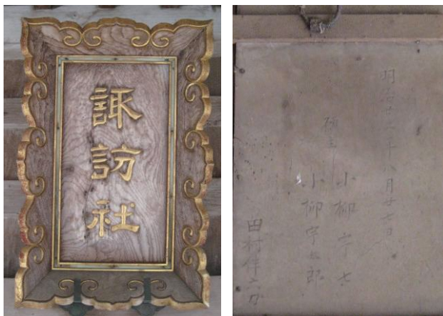
写真2 仲町の諏訪神社拜殿神額 明治22年(51歳)製作。材は櫨の玉杻の良材で、仕口は木釘を用いて比較的簡単な造り。願主の1人小柳宇七は、小柳宇七商店(小柳建具店)を営んでおり、製作を田村伴六に依頼したと考えられる。「田村伴六刀」とあるため、彫刻のみを頼まれたとも考えられるが、定かではない。
